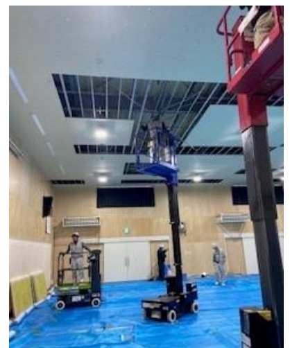
多目的室の天井と床の張替工事
