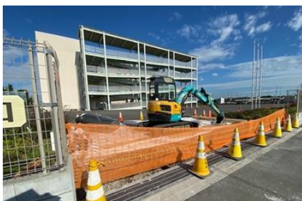
外玄関、南門の付け替え工事
