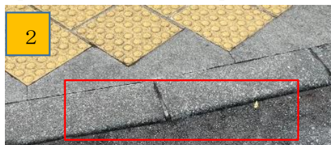
【横断歩道（段差なし）】
